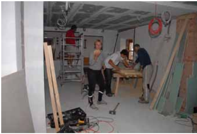
Ausbau neue Küche
